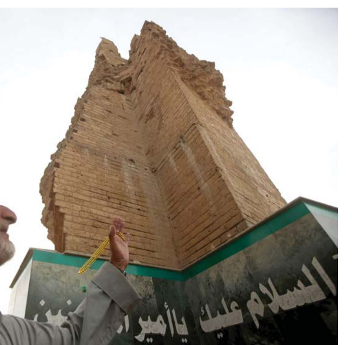
بقايا مسجد الإمام علي في البصرة
