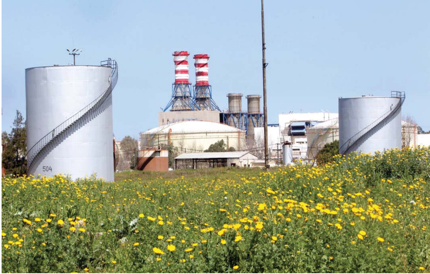
نفاد الوقود يرغم لبنان على إغلاق المحطة الكهربائية في الزهراني
