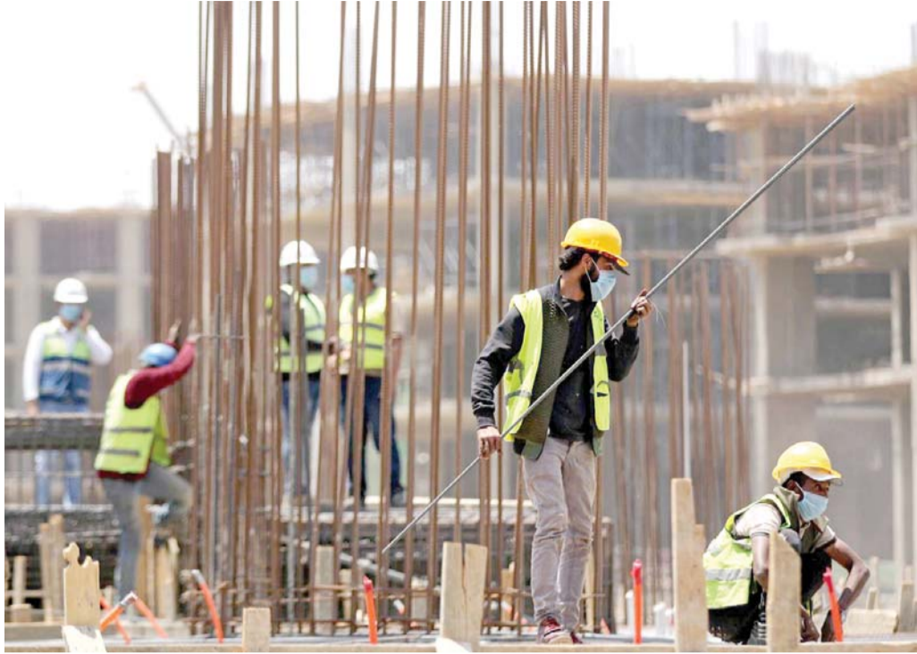
متابعة لصيقة لأعمال البناء
