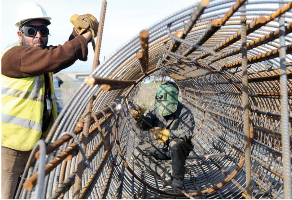
إعادة تركيب أسس القطاع
